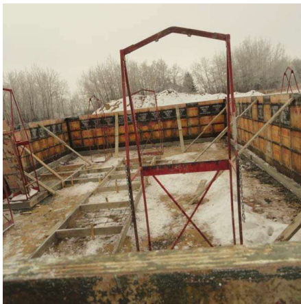
Grandeur et profondeur de l'empattement
