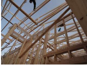
Espacement des éléments de charpente
