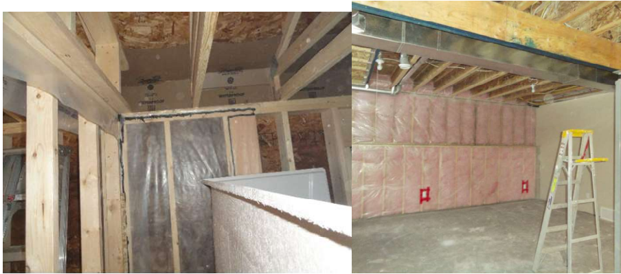
Installation des pare-vapeur et de l'isolation
